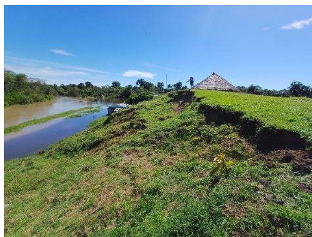
Fotografía N° 2. Se observa el río alledaño, al sector de la Comunidad campesina de Huaman Urco, la Posta esta a menos de 20 metros de la zona de erosión donde se requiere de protección
