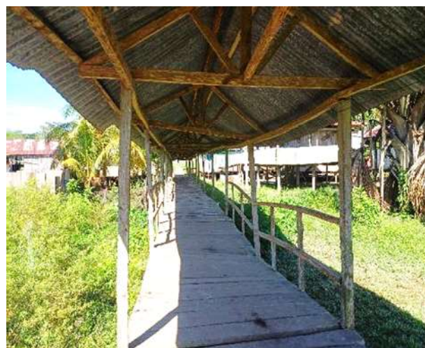
Fotografía N° 4. Se observa el puente en época donde el río baja el caudal y que se requiere de protección
